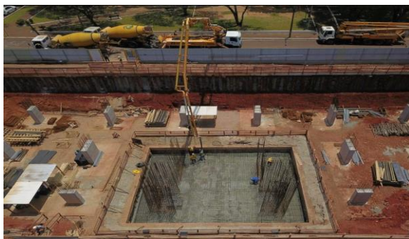
Figura 2: Bloco de fundação
