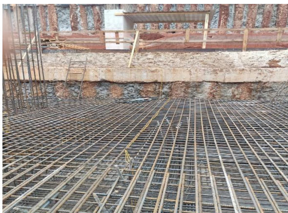
Figura 9: Cabos termopar (cabos amarelos) inseridos no bloco
