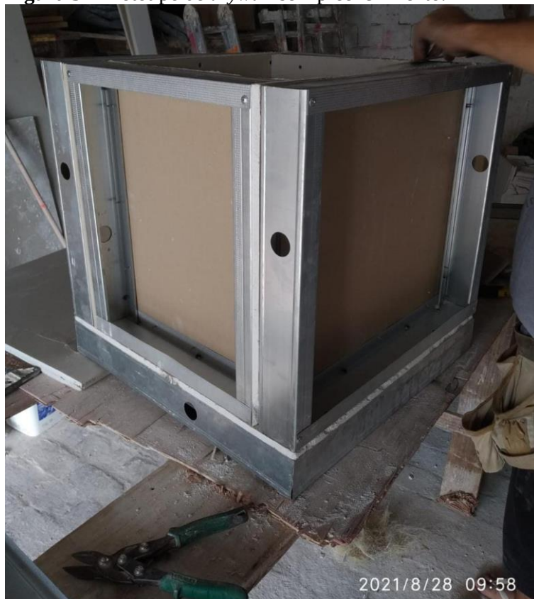
Figura 5 – Protótipo de drywall sem preenchimento.
