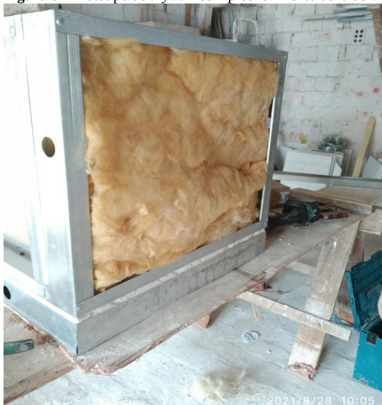
Figura 6 – Protótipo de drywall com preenchimento de lã de vidro.
