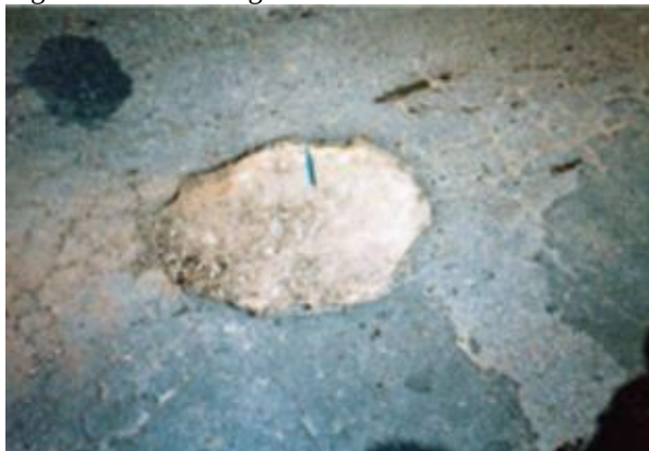
Figura 3: Panela atingindo a base.
