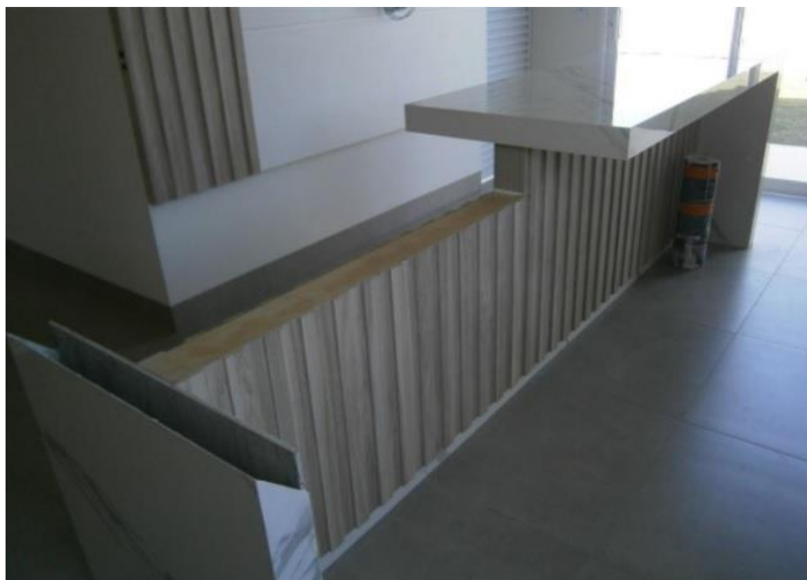
Figura 6 – Estrutura confeccionada com porcelanato
