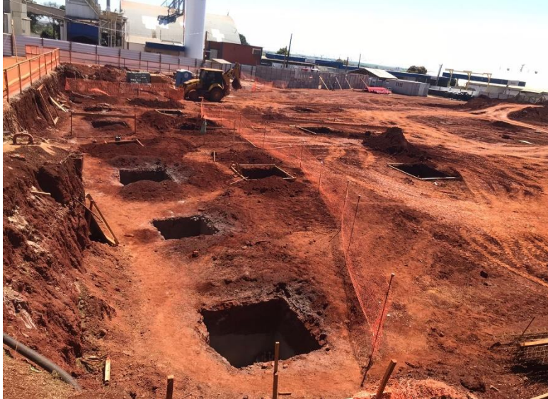
Figura 8: Escavação dos blocos
