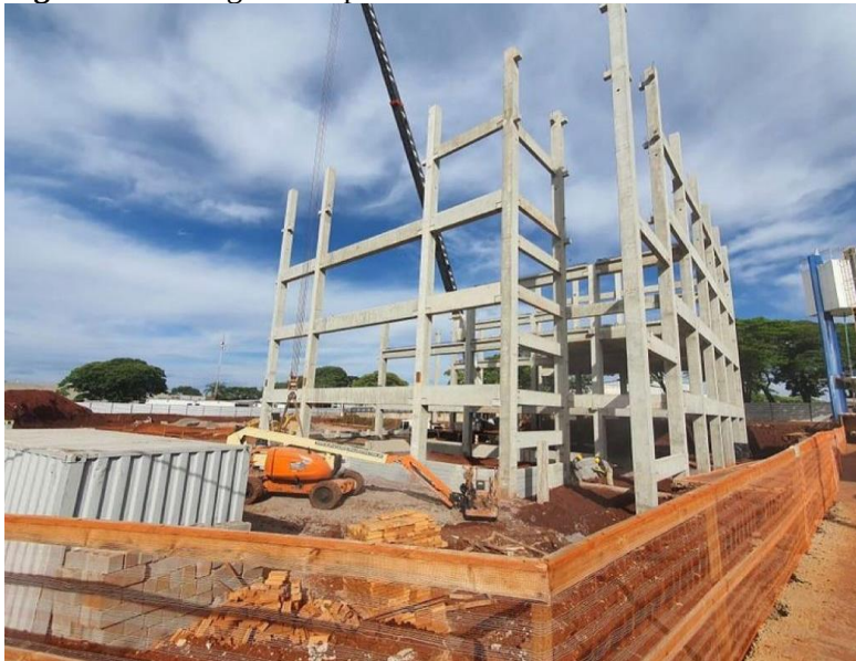
Figura 9: Montagem dos pré-moldados
