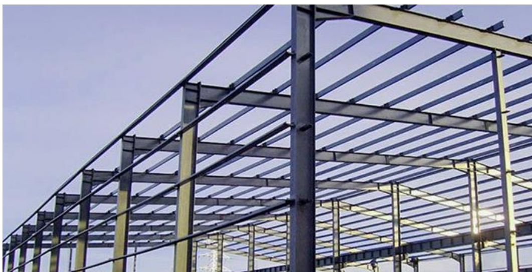
Figura 9: Colunas de estruturas metálicas em viga W.
