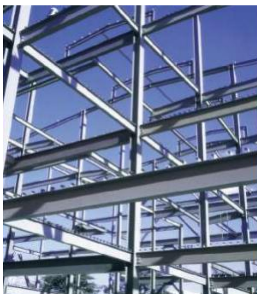
Figura 4: Aço em estrutura metálica.
