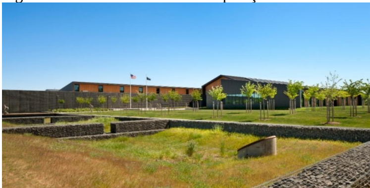
Figura 01 – Fachada Centro de Preparação Coronel Nesmi
