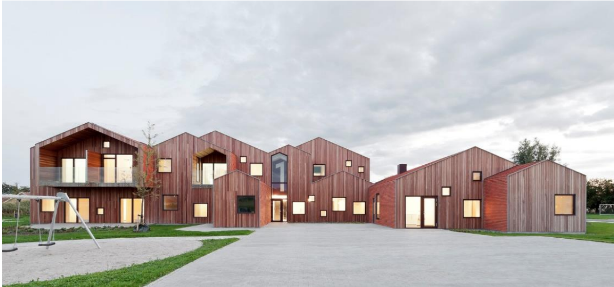
Figura 10: entrada vista da fachada
