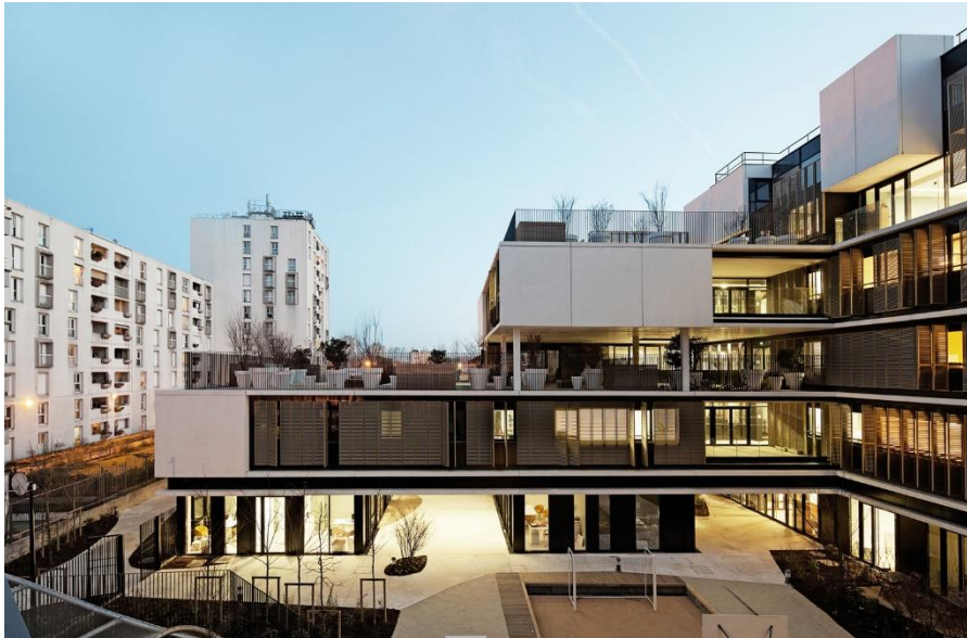
Figura 5: vigas, pilares em concreto
