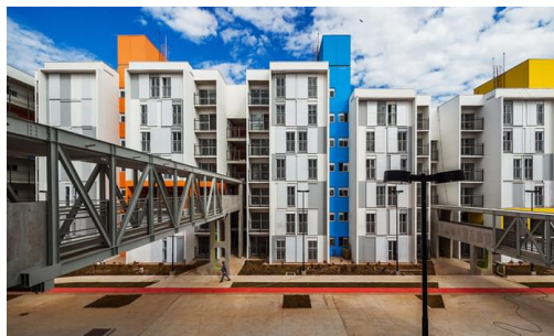
Figura 1- Acessos e passarelas metálicas
