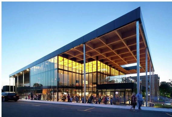
Figura 07 – Materiais e cobertura
