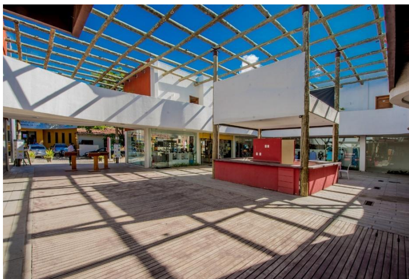
Imagem 03: Interior do Shopping Villa da Pipa/RN
