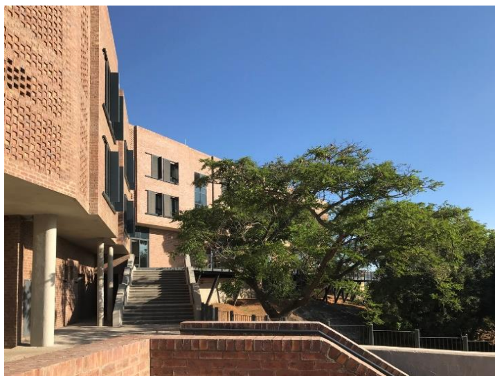
Figura 02 – Fachada Oeste Edifício Residencial Estudantil do Campus da Universidade de Mpumalanga-Mbombela
