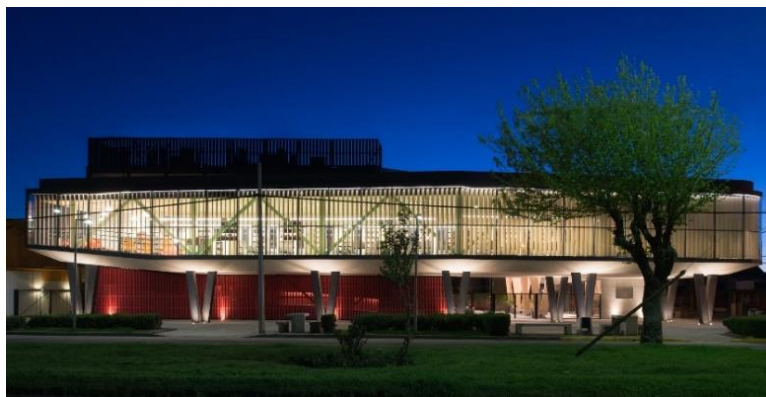
Figura 07 – Fachada do Centro Cultural, Chile
