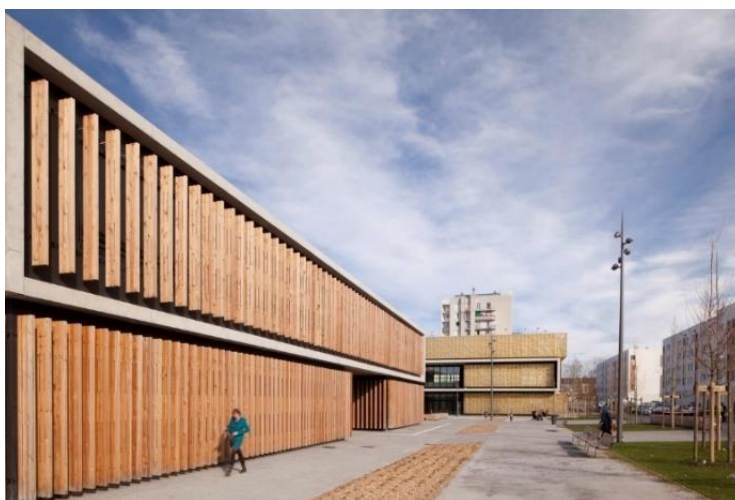
Figura 04 – Fachada trabalhada na madeira e brise-soleil vertical
