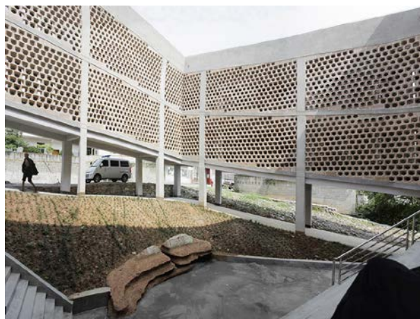
Figura 25 – Hospital Angdong (Pátio interno)
