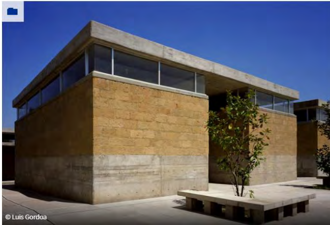
Figura 3 – Linhas no concreto
