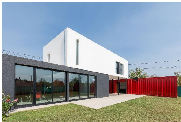
Figura 2: Casa híbrida de container e alvenaria
