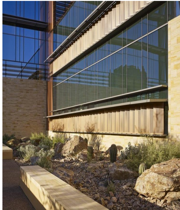
Figura 16 – Centro do Câncer da Universidade do Arizona (Jardim - Detalhe)
