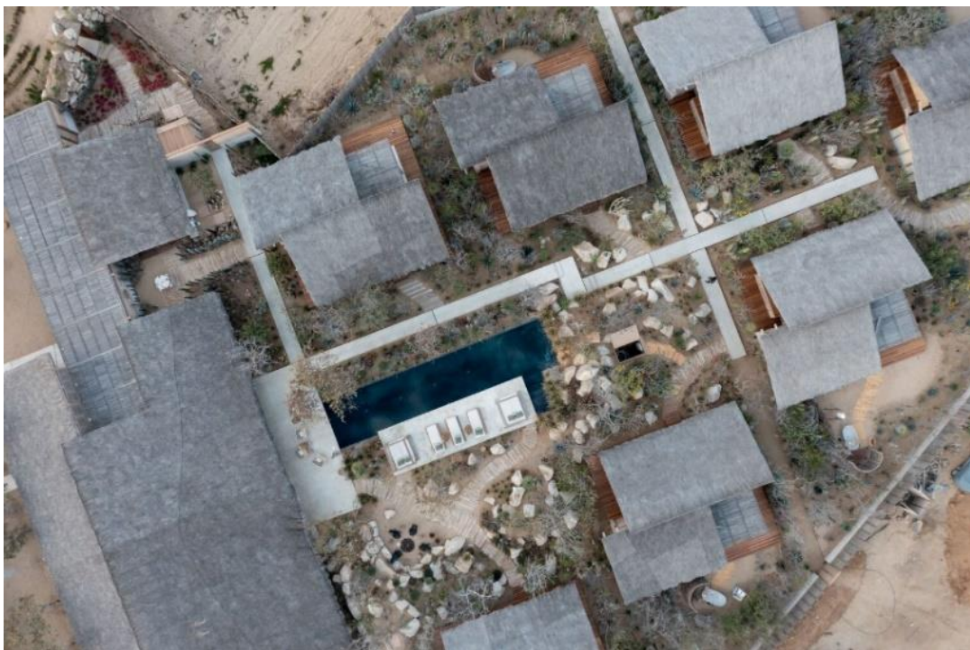
Figura 28: Empregaram artesãos locais e técnicas tradicionais de construção.
