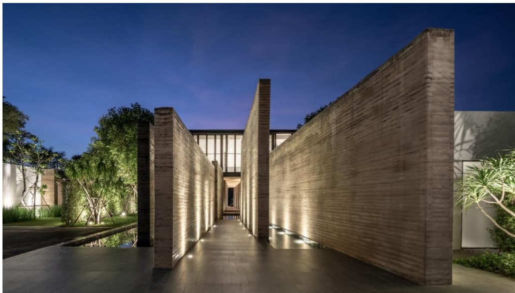
Figura 55: Paredes de terra batida.
