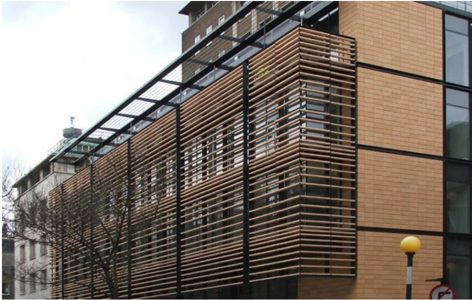
Figura 23: Brise de madeira horizontal.
