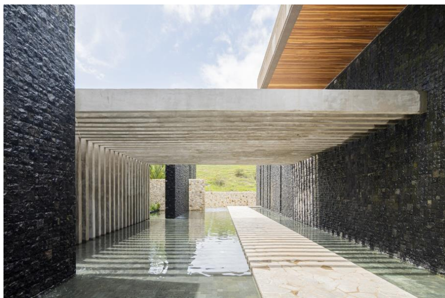
Figura 48: As vigas concretas trazer as sombras integra essa composição estética.
