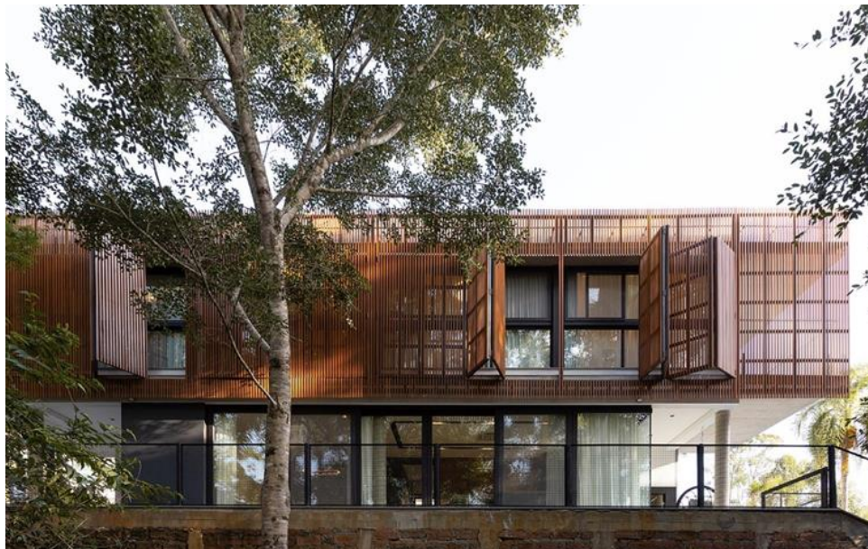
Figura 22: Brise de madeira vertical.
