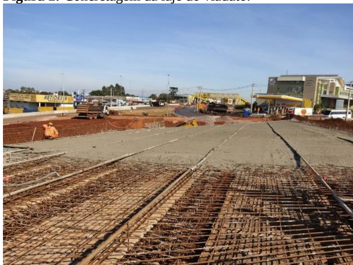
Figura 2: Concretagem da laje do viaduto.
