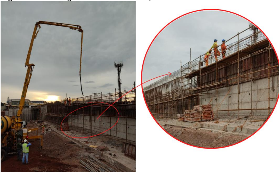
Figura 4: Concretagem do muro de contenção.
