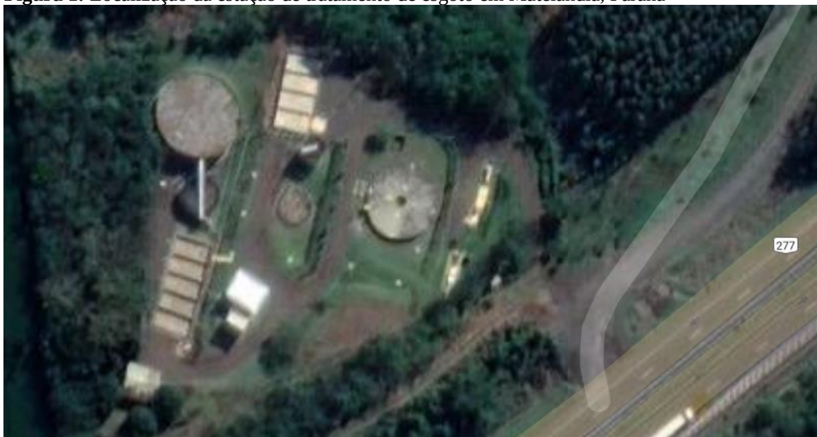
Figura 1: Localização da estação de tratamento de esgoto em Matelândia, Paraná
