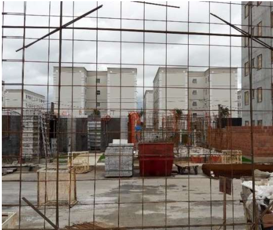
Figura 1 - Armadura de reforço
