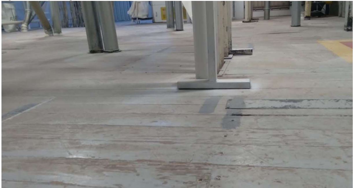
Figura 2: Situação do piso de madeira do moinho
