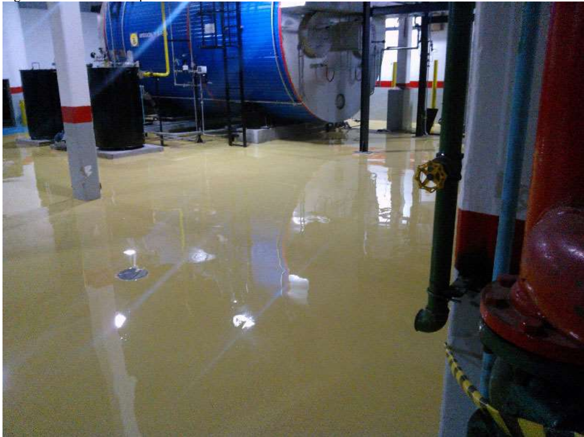
Figura 4: Piso de resina epóxi
