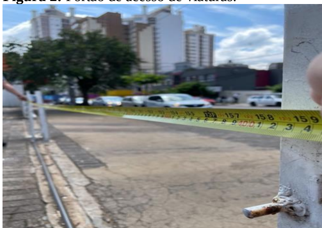
Figura 2: Portão de acesso de viaturas.
