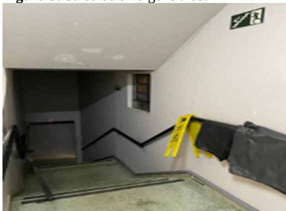
Figura 5: Saída de emergência 03.
