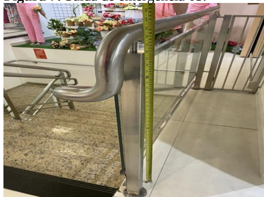
Figura 7: Saída de emergência 05.
