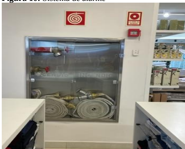
Figura 10: Sistema de alarme
