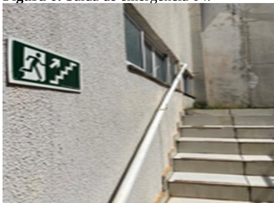
Figura 6: Saída de emergência 04.
