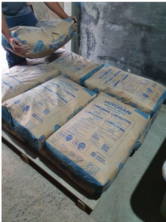
Figura 6 – Descarga no local de armazenamento dos cimentos.
