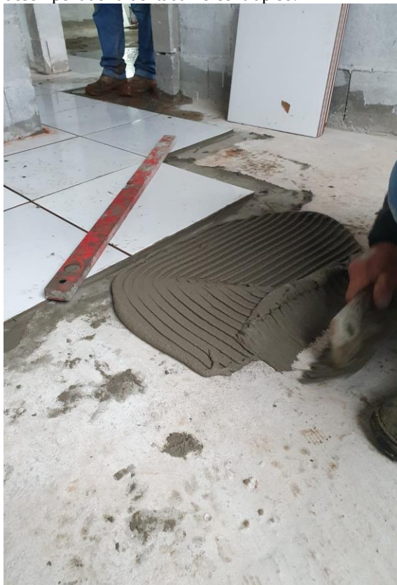
Figura 3 - Aplicação da argamassa com desempenadeira dentada no contrapiso.
