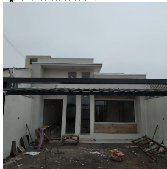
Figura 2: Fachada da obra B.
