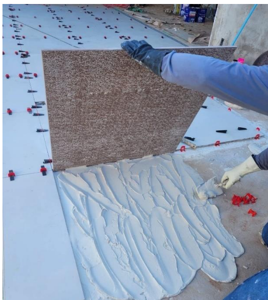
Figura 5 – Aplicação da argamassa.
