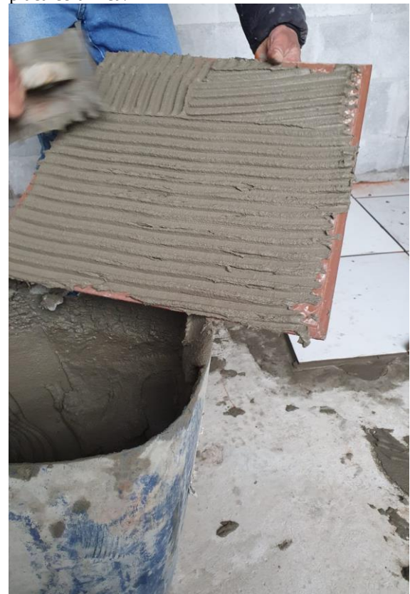
Figura 4 - Aplicação da argamassa no tardo da placa cerâmica.
