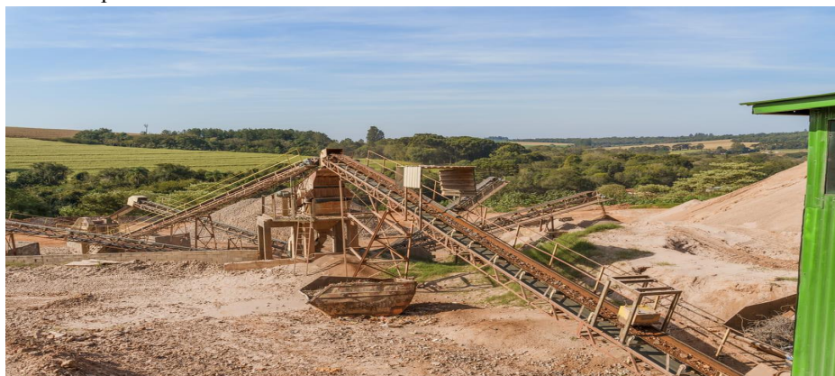
Figura 2: Estrutura da empresa
