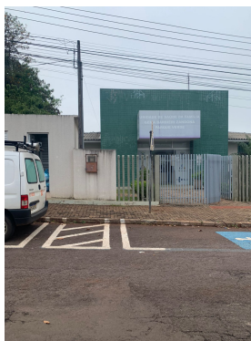
Figura 12 - Fachada frontal USF Parque Verde
