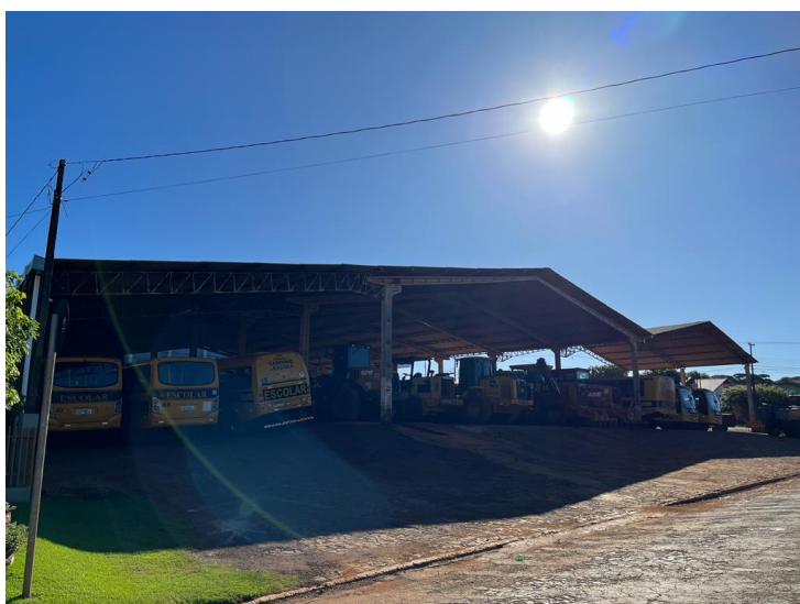
Figura 22 – Parque de Máquinas Municipal – Vista Rua Luiz Lorenzoni
