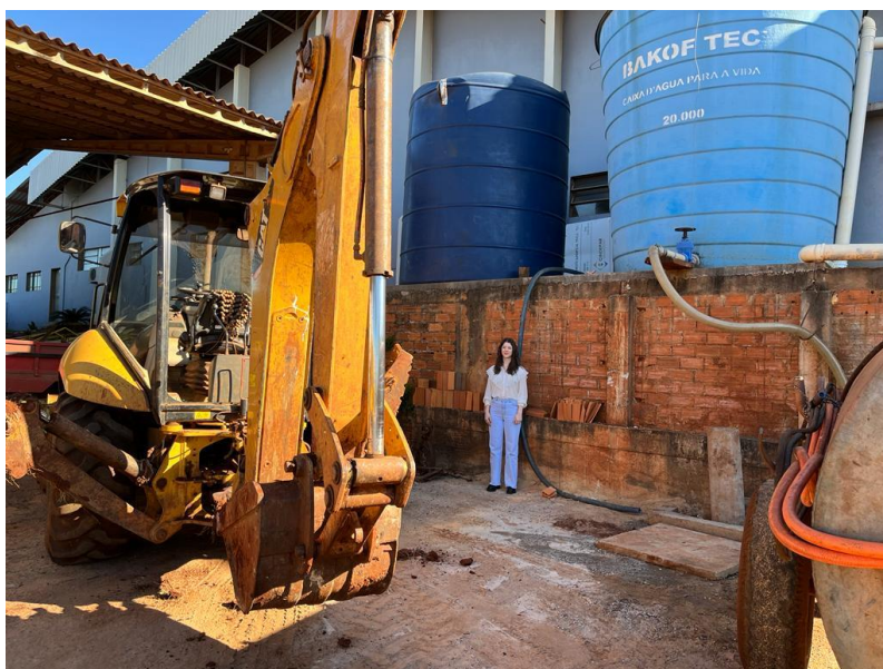
Figura 23 – Muro de arrimo com escala humana
