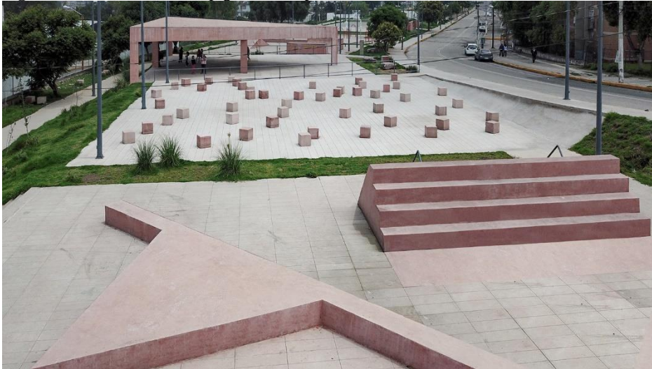
Figura 16 – Concreto armado pigmentado e placas de concreto
