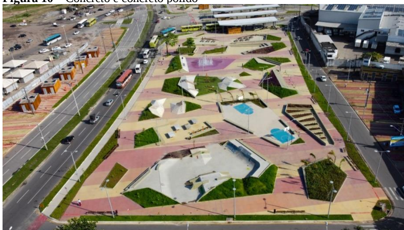
Figura 10 – Concreto e concreto polido
