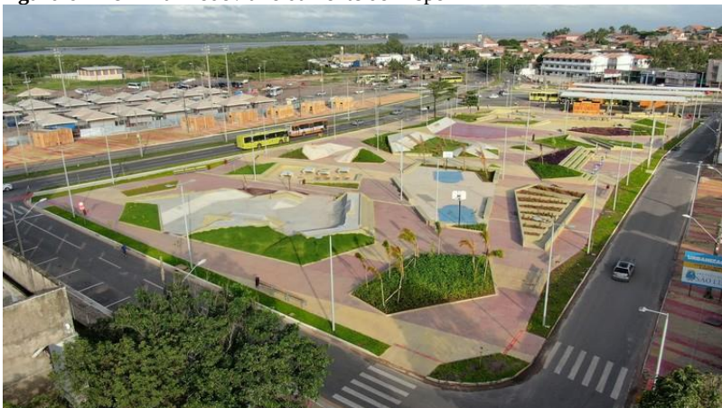
Figura 6 – Terminal Rodoviário da Fonte do Bispo
