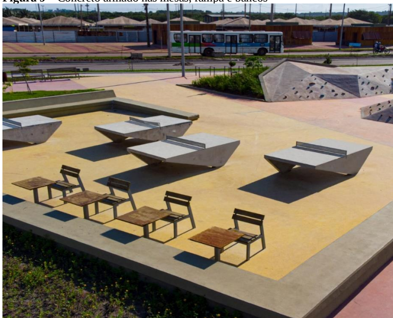
Figura 9 – Concreto armado nas mesas, rampa e bancos
