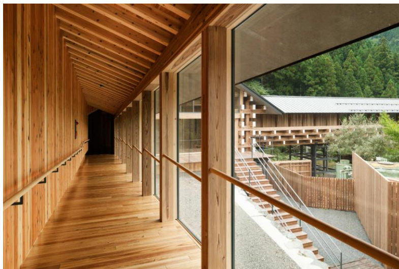
Figura 6 – Interior do Museu e as estruturas de madeira
