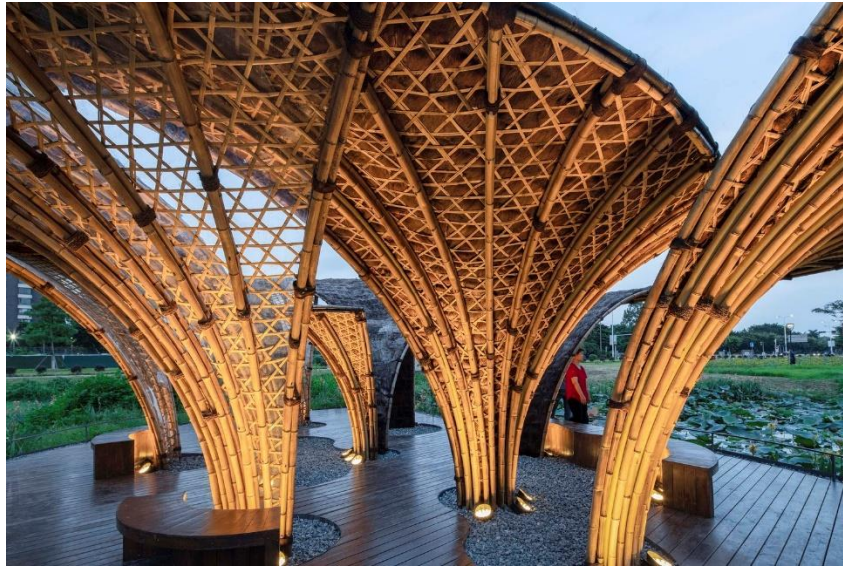
Figura 8 – Estrutura de bambu
