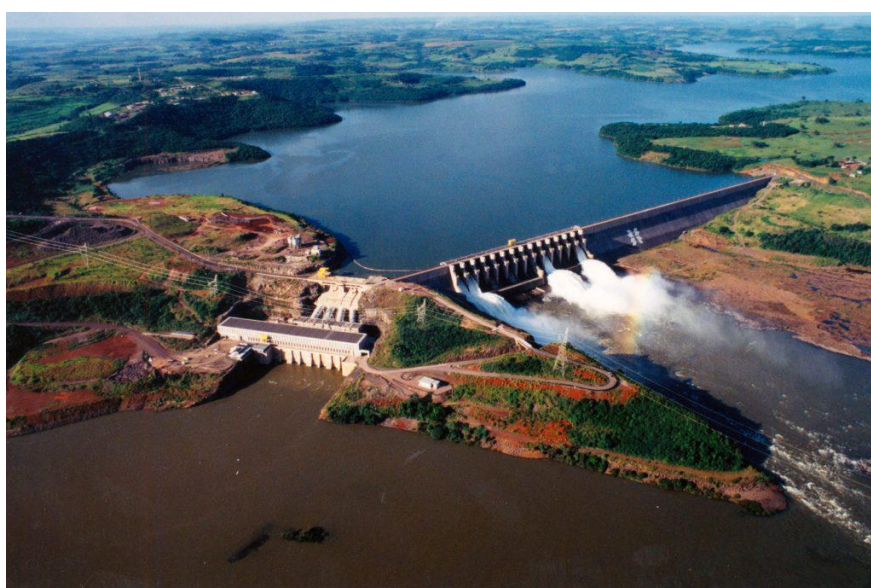
Figura 01: Usina Hidrelétrica Governador José Richa
