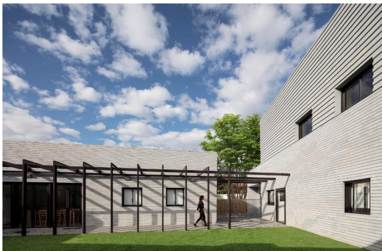
Figura 03 – Espaço interno do abrigo.
