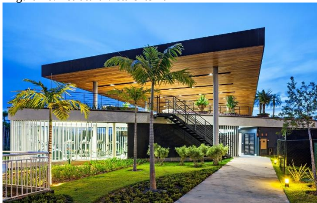
Figura 20: Estrutura vista externa
