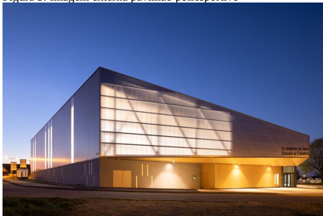
Figura 3: Imagem externa pavilhão poliesportivo
