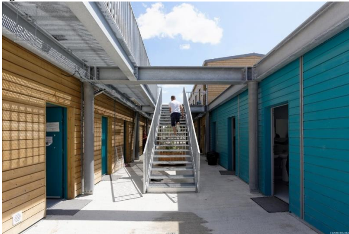
Figura 6: Escadaria externa Centro de Acolhimento
