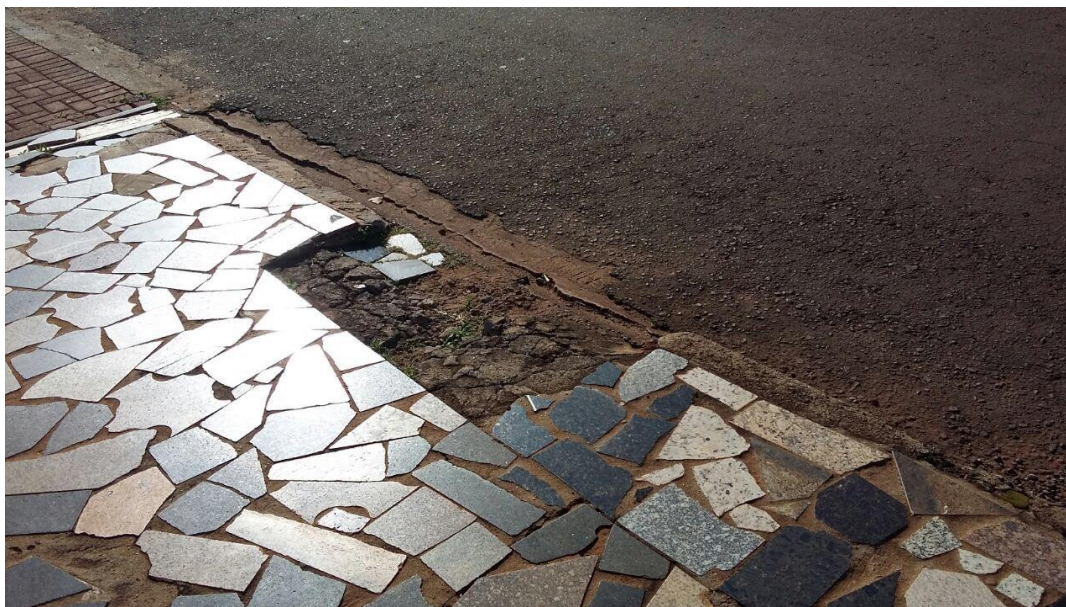
Imagem: Calçada existente irregular, pois o piso não é antiderrapante, não possui a inclinação exigida pelas leis vigentes, não possui indicações de sinalização (piso podotátil, rampa, etc) e para a legislação municipal não se enquadra em calçada com faixa permeável.
