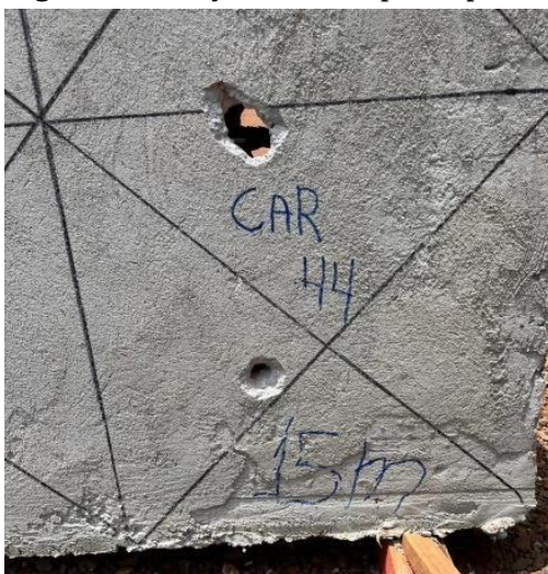
Figura 12: Reação da frente protótipo de bloco cerâmico.
