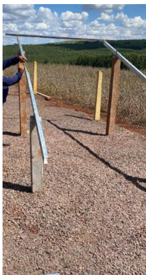
Figura 3.2 – Instalação dos postes e trilhos.
