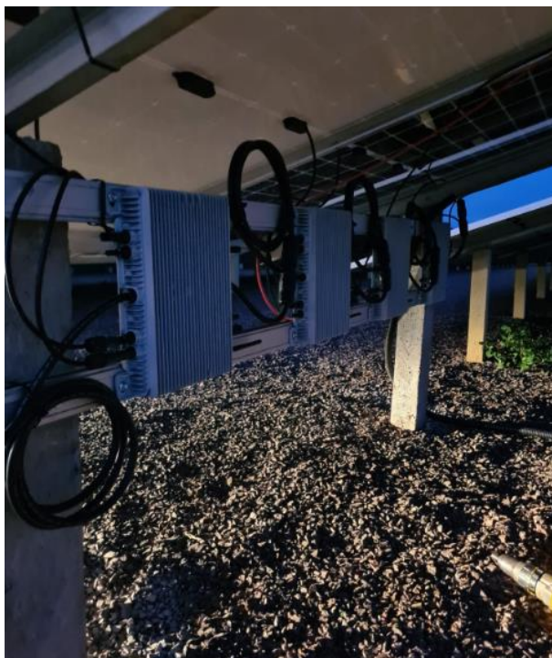
Figura 4.1 – Conexão dos módulos nos micros inversores.
