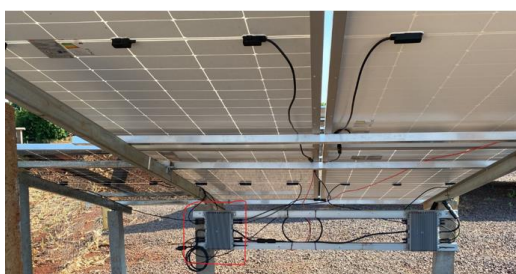
Figura 3.5 – Conexão dos módulos no microinversor.
