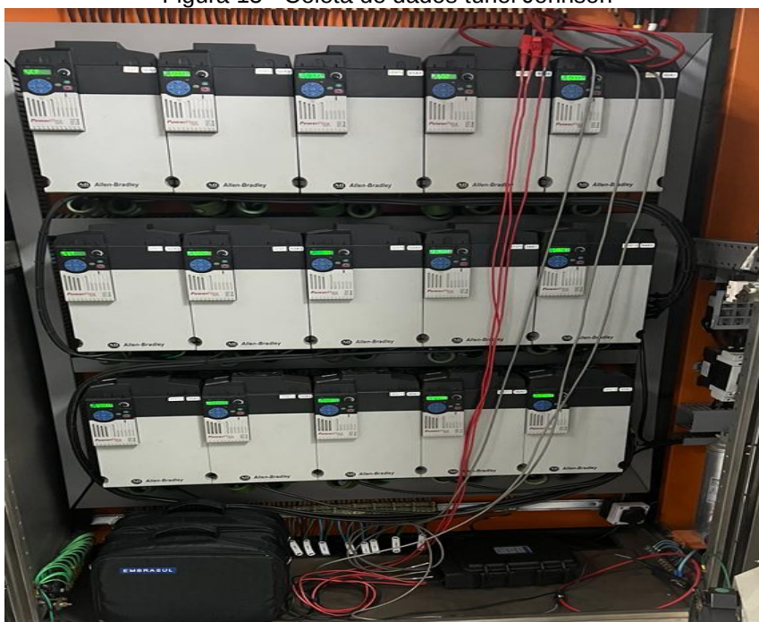
Figura 15 - Coleta de dados túnel Johnson
