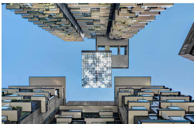
Figura 13: Balanço com heliostatos redirecionando os raios solares.
