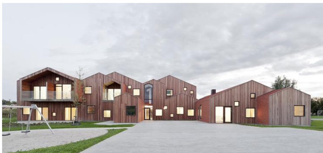
Figura 01. Casa de acolhimento para menores
