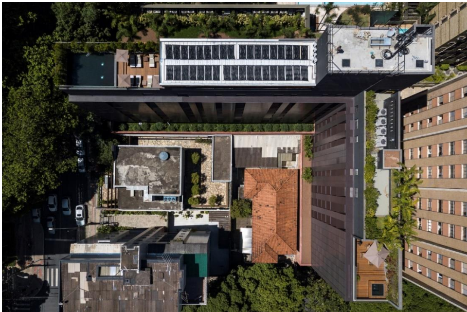
Figura 20: Vista da cobertura do Hotel Fasano
