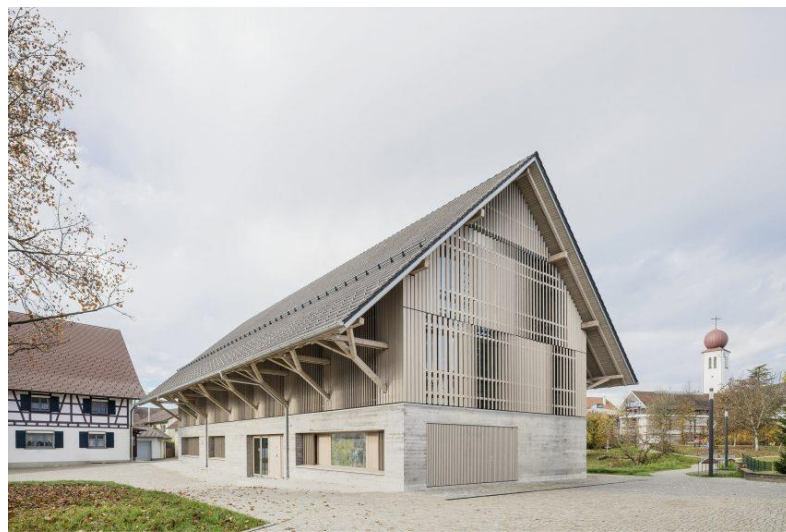
Figura 3- Fachada da Biblioteca Kressonbronn.
