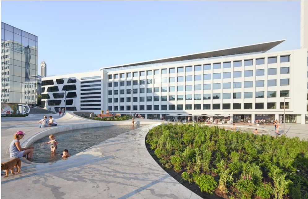
Imagem 5 – Requalificação Urbana da Praça Unidade
