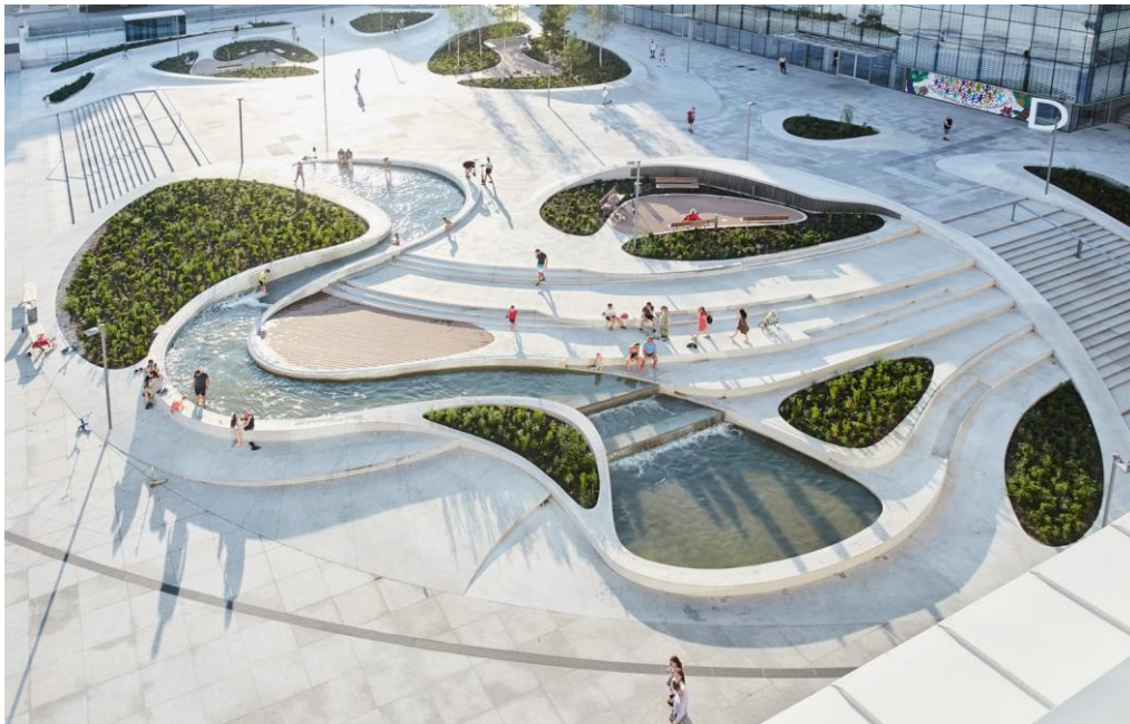
Imagem 4 – Requalificação Urbana da Praça Unidade
