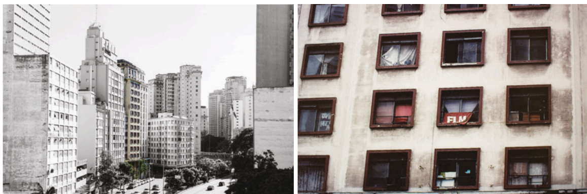
Figuras 5 e 6. Na esquerda Hotel Cambridge na Avenida 9 de Julho, e na direita o hotel após a ocupação pelo FLM (CAIRNS, et al , 2017).
