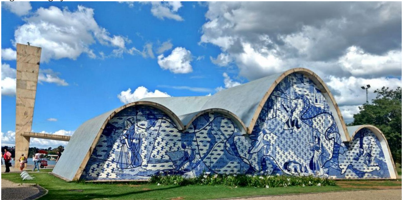
Figura 02: Igreja São Francisco de Assis, Belo Horizonte.
