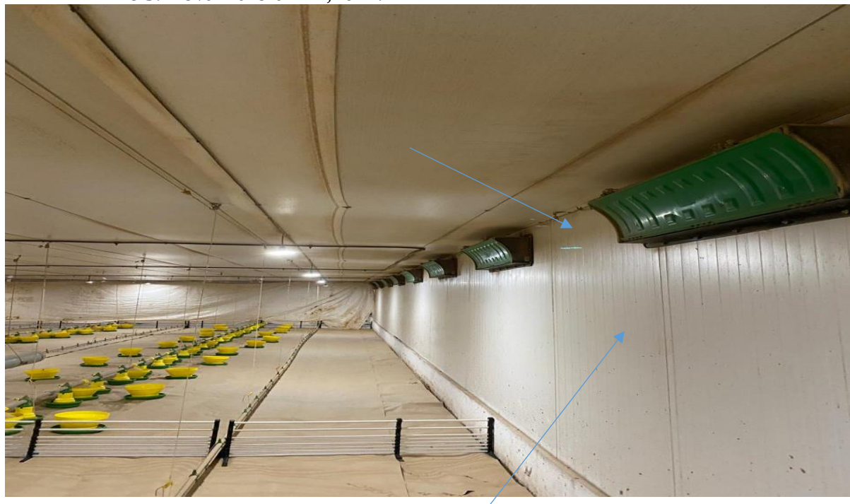
Figura 2 – Imagem das aberturas nas paredes laterais – “INLETS”, presente nos Tratamentos 1 e 3. Nova Aurora-PR, 2024.
