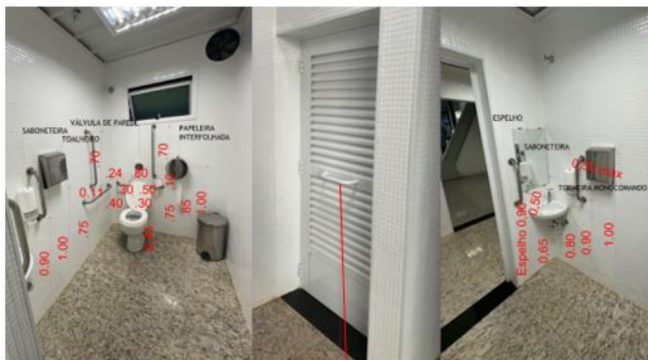
Figura 9 – Sanitário acessível terminal de passageiros.
