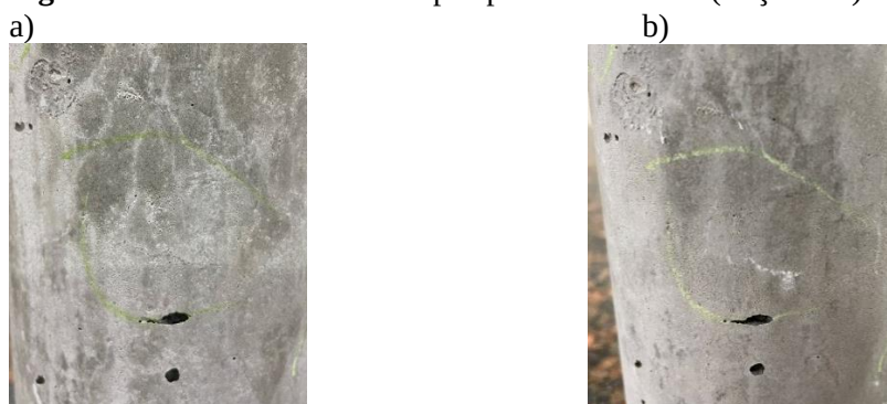
Figura 15: Abertura de fissura após processo de cura (traço TC2)
