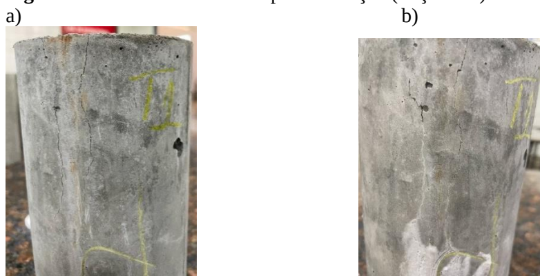
Figura 13: Abertura de fissura após fissuração (traço TC1).
