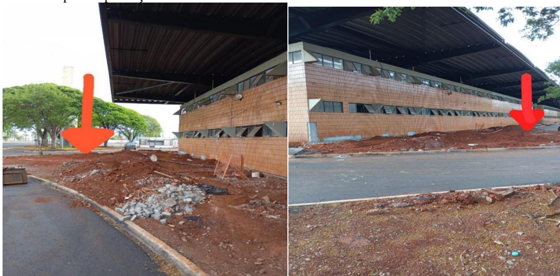
Figura 5: Local para implantação do reservatório.
