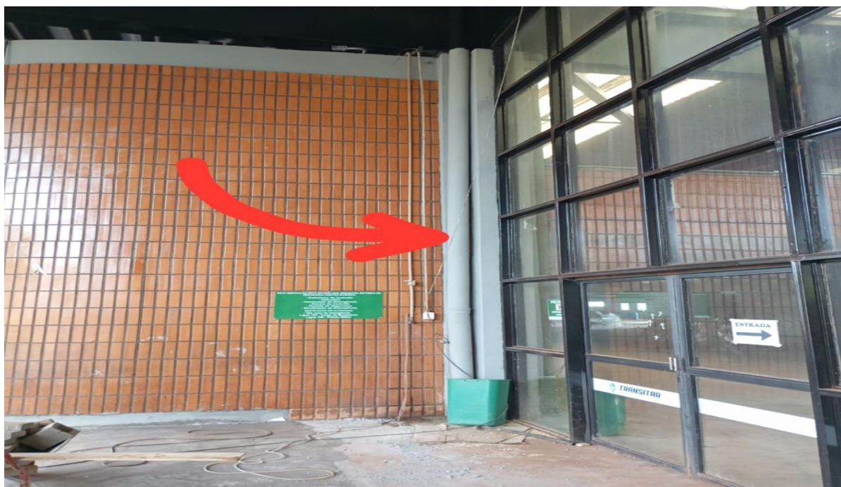
Figura 4: Tubulação vertical da pluvial.
