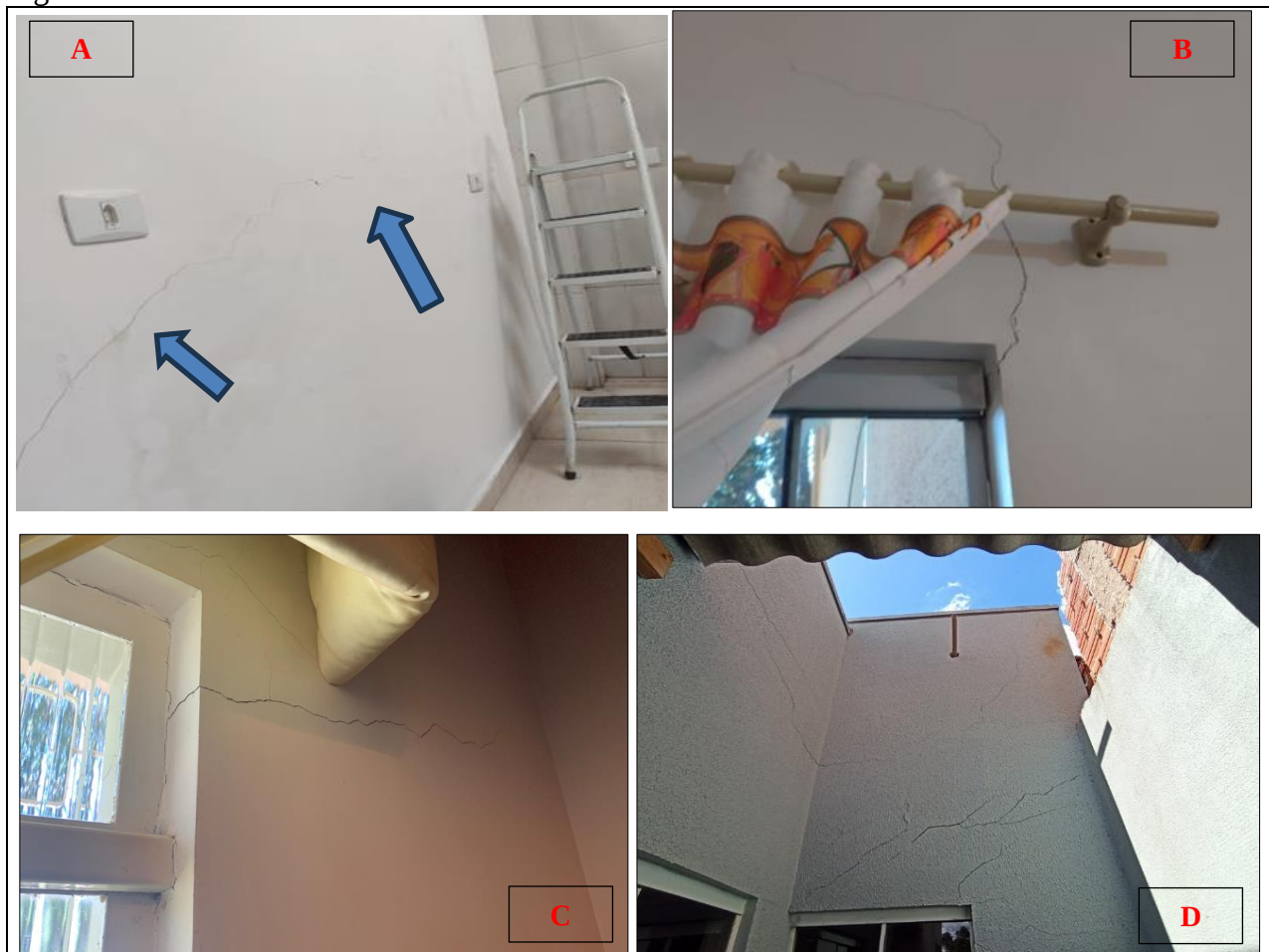
Figura 09 - Trincas.
