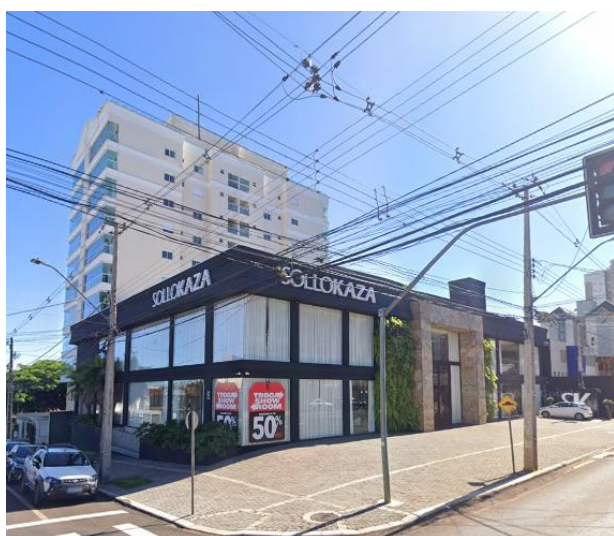
Figura 63: Sala comercial e edifício residencial na rua Recife.
