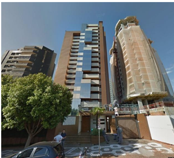
Figura 21: Edifício Maison Royale.
