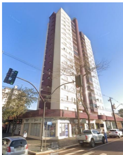
Figura 26: Edifício Laury Sonda.
